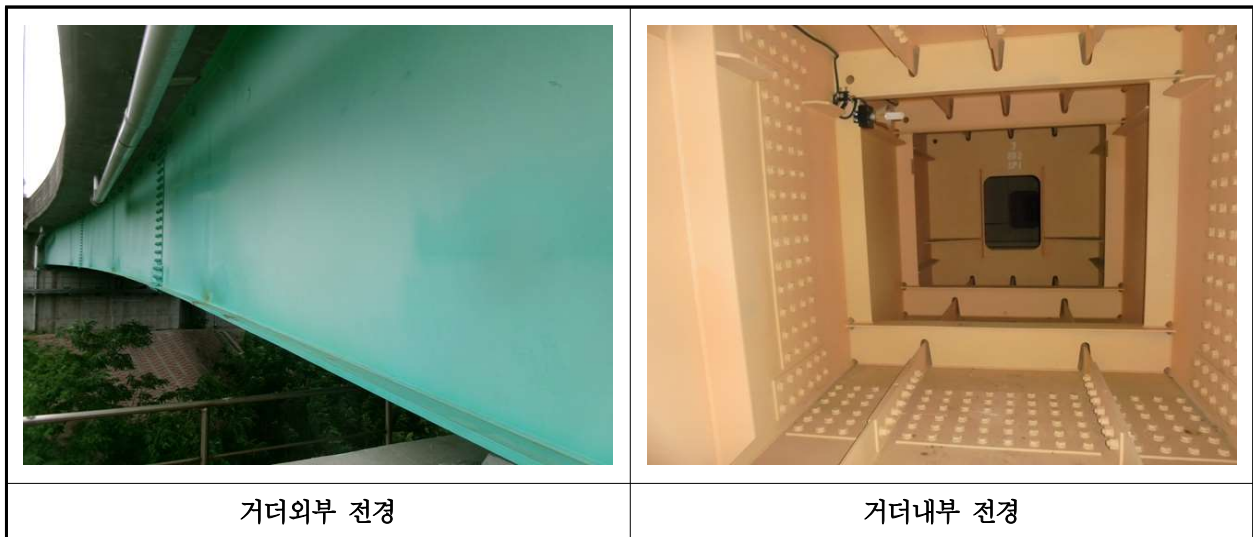
【사진 21.3.4】 거더 전경
