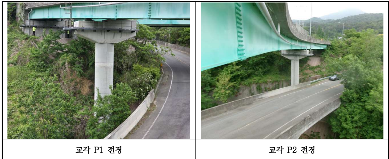
【사진 21.3.10】 교각 전경
