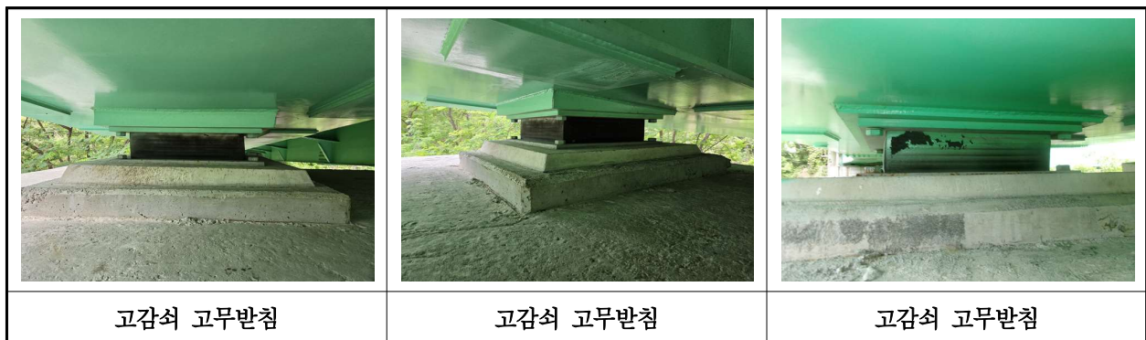
【사진 21.3.13】 교량받침 전경
