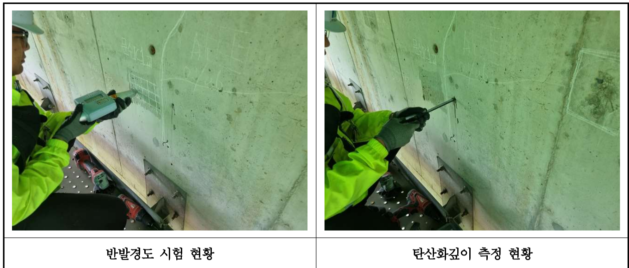
【사진 21.4.1】 콘크리트 내구성조사 현황
