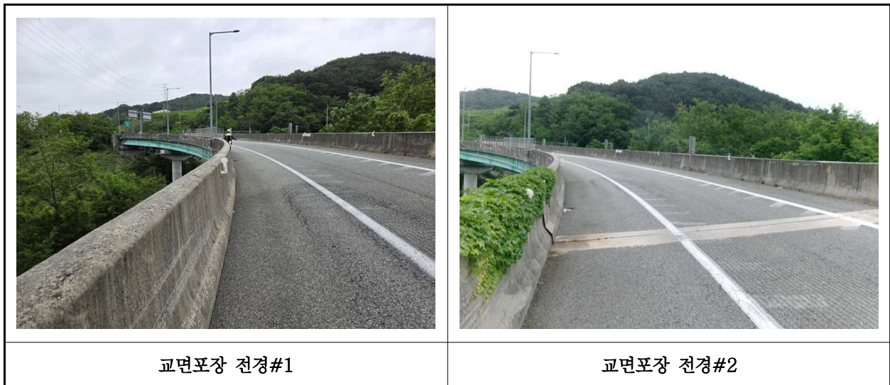
【사진 21.3.20】 교면포장 전경
