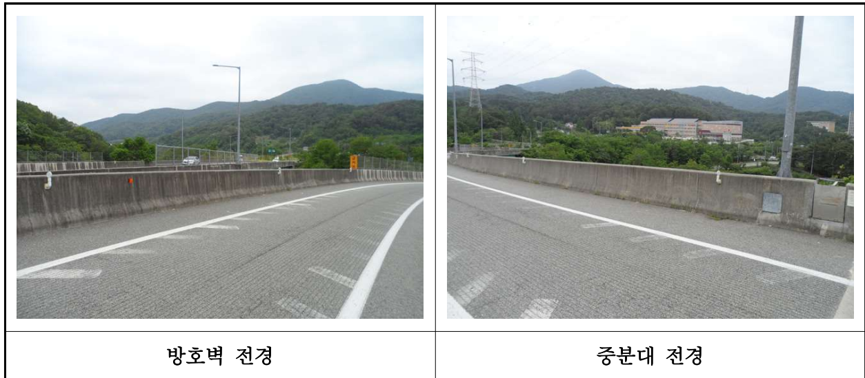
【사진 21.3.24】 방호벽 및 중분대 전경
