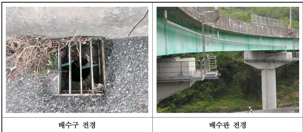
【사진 21.3.22】 배수시설 전경
