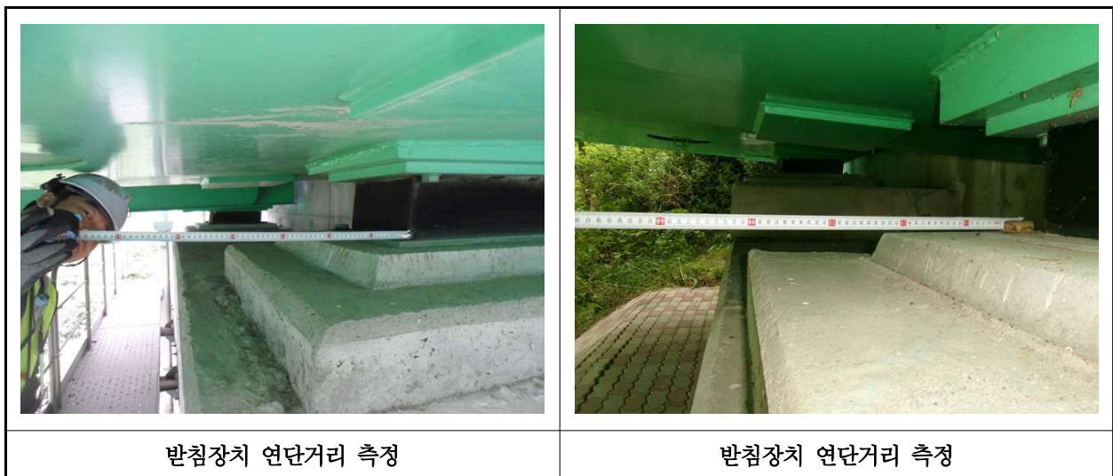
【사진 21.3.15】 교량받침장치 연단거리측정
