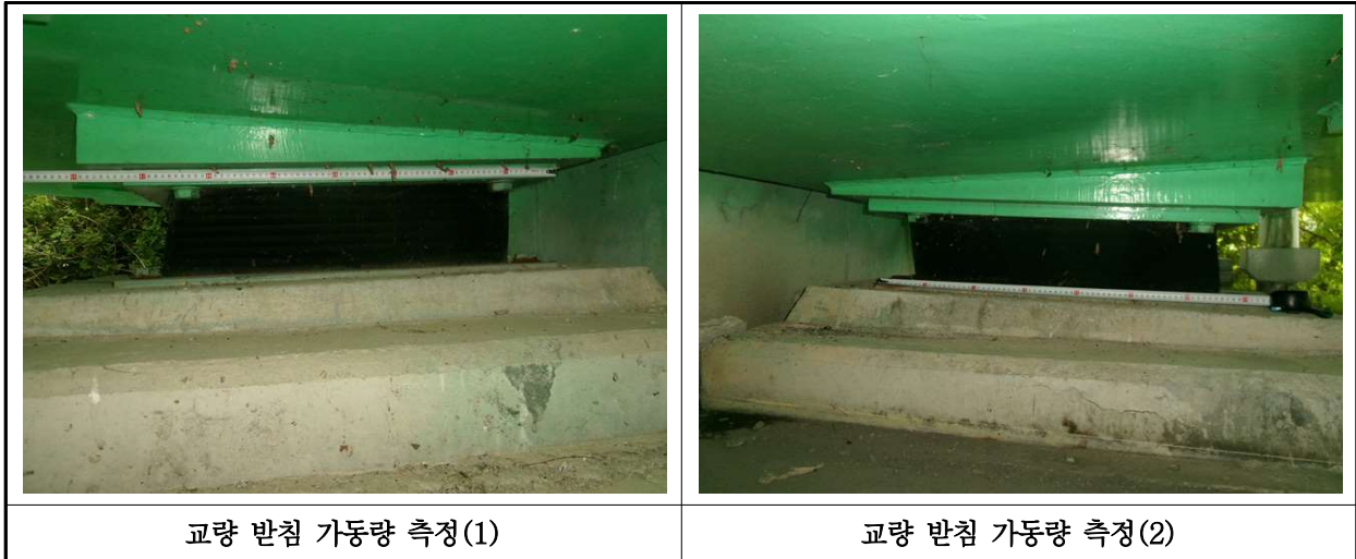
【사진 21.3.16】 교량받침 이동량 측정
