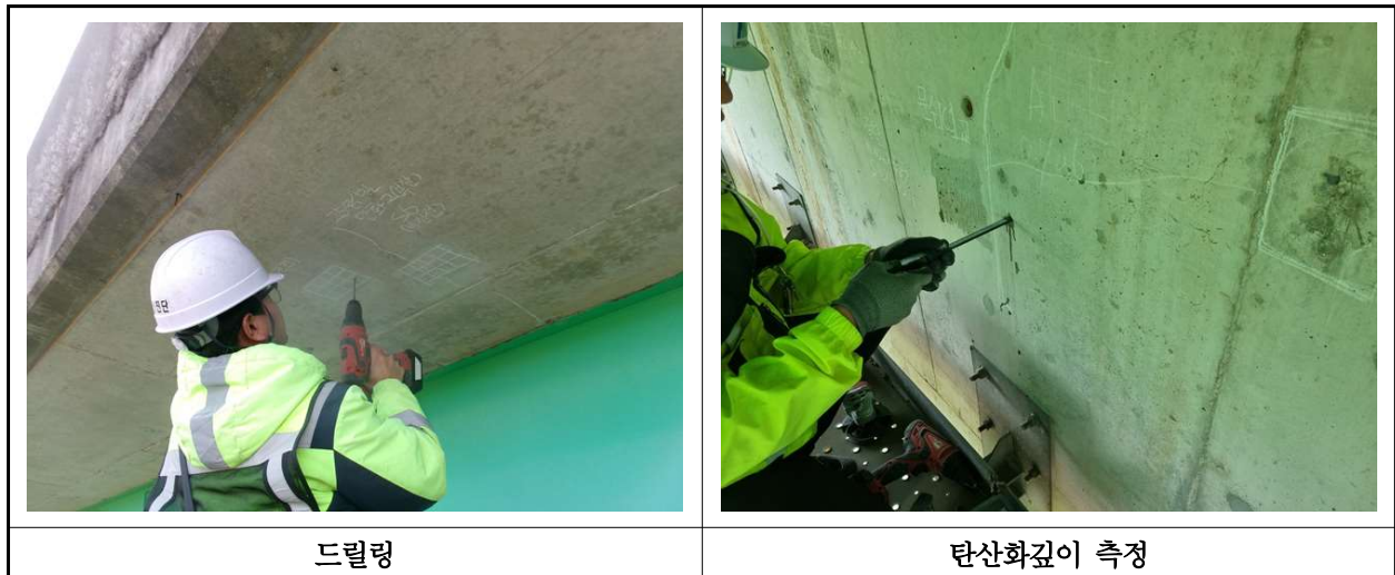
【사진 21.4.3】 탄산화 깊이 측정 현장사진
