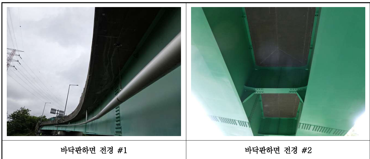
【사진 21.3.2】 바닥판하면 전경
