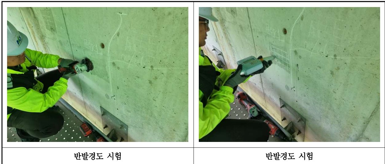
【사진 21.4.2】 반발경도시험 현장사진
